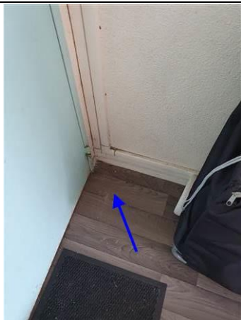
Photo n° PhA126 Localisation : 6ème étage - N6-5 Chambre 614 Ouvrage : 5 - Planchers et planchers techniques - Revêtements de sols Partie d'ouvrage : Sol Description : Lino + colle + ragréage + colle
