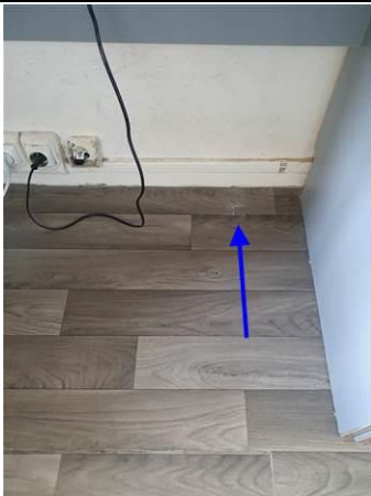
Photo n° PhA148 Localisation : 7ème étage - N7-15 Chambre 710 Ouvrage : 5 - Planchers et planchers techniques - Revêtements de sols Partie d'ouvrage : Sol Description : Lino + colle + ragréage
