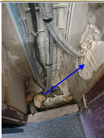
Photo n° PhA206 Localisation : 10ème étage - N10-39 Circulation Ouvrage : 3 - Parois verticales intérieures - Cloisons sèches (assemblées, préfabriquées) Partie d'ouvrage : Mur Description : Scellement plâtre
