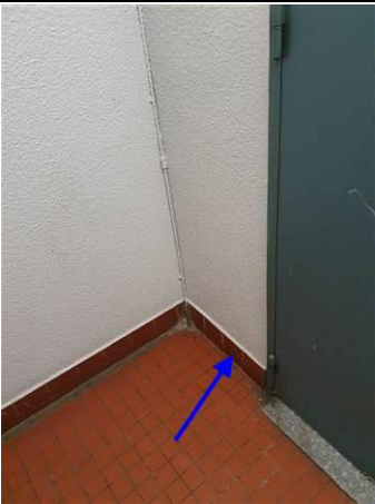
Photo n° PhA228 Localisation : 7ème étage - N7-2 Palier Ouvrage : 3 - Parois verticales intérieures - Murs et cloisons maçonnés Partie d'ouvrage : Plinthe Description : Matériau dur de type joint ciment (gris)
