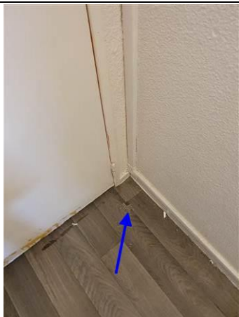
Photo n° PhA210 Localisation : 10ème étage - N10-33 Chambre 1005 Ouvrage : 5 - Planchers et planchers techniques - Revêtements de sols Partie d'ouvrage : Sol Description : Lino + ragréage + colle
