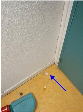
Photo n° PhA021 Localisation : 1er étage - N1-27 Chambre 119 Ouvrage : 5 - Planchers et planchers techniques - Revêtements de sols Partie d'ouvrage : Sol Description : Ragréage + colle noire
