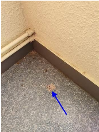
Photo n° PhA066 Localisation : 3ème étage - N3-41 Circulation Ouvrage : 5 - Planchers et planchers techniques - Revêtements de sols Partie d'ouvrage : Sol Description : Ragréage + colle noire
