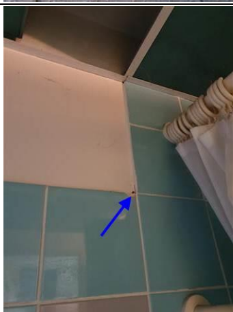
Photo n° PhA002 Localisation : Rez de chaussée - N0-13 Salle de douche Ouvrage : 5. Revêtements de sol et de murs - Revêtements de mur Partie d'ouvrage : Mur Description : Faïence + colle + joint
