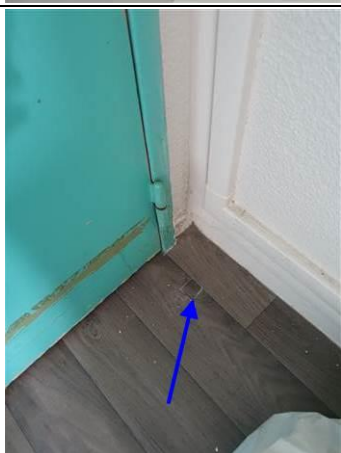
Photo n° PhA174 Localisation : 8ème étage - N8-21 Chambre 818 Ouvrage : 5 - Planchers et planchers techniques - Revêtements de sols Partie d'ouvrage : Sol Description : Lino + colle + ragréage
