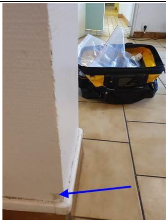
Photo n° PhA242 Localisation : Rez de chaussée - N0-26 Salle de réunion Ouvrage : 3 - Parois verticales intérieures - Poteaux Partie d'ouvrage : Poteau Description : Toile de verre + colle + enduit + peinture
