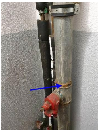
Photo n° PhA232 Localisation : 7ème étage - N7-2 Palier Ouvrage : 6 - Conduits et accessoires intérieurs - Conduits de fluides (air, eau, vapeur, fumée, échappement, autres fluides) Partie d'ouvrage : Conduit Description : Filasse
