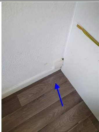
Photo n° PhA114 Localisation : 5ème étage - N5-64 Chambre 530 Ouvrage : 5 - Planchers et planchers techniques - Revêtements de sols Partie d'ouvrage : Sol Description : Lino + colle + ragréage + colle noire
