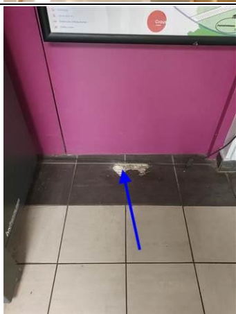
Photo n° PhA254 Localisation : Rez de chaussée - N0-32 Entrée Ouvrage : 5 - Planchers et planchers techniques - Revêtements de sols Partie d'ouvrage : Sol Description : Carrelage + colle
