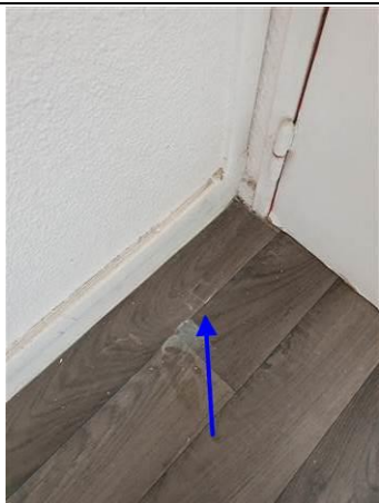
Photo n° PhA156 Localisation : 7ème étage - N7-42 Chambre 723 Ouvrage : 5 - Planchers et planchers techniques - Revêtements de sols Partie d'ouvrage : Sol Description : Lino + colle + ragréage
