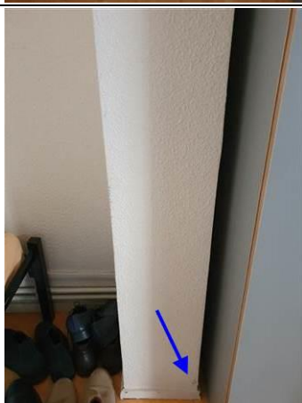
Photo n° PhA006 Localisation : Rez de chaussée - N0-2 Chambre 3 Ouvrage : 5. Revêtements de sol et de murs - Revêtements de murs Partie d'ouvrage : Poteau Description : Matériau de type peinture (beige) (clair) ; matériau semi-dur de type enduit (blanc) ; matériau souple fibreux de type papier, carton (blanc) ; matériau semi-dur de type enduit (blanc) en traces
