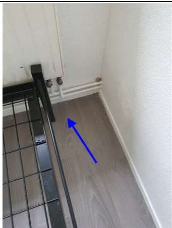
Photo n° PhA216 Localisation : 10ème étage - N10-44 Chambre 1023 Ouvrage : 5 - Planchers et planchers techniques - Revêtements de sols Partie d'ouvrage : Sol Description : Lino + colle + ragréage
