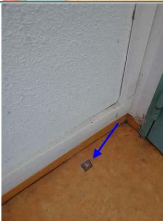
Photo n° PhA023 Localisation : 1er étage - N1-31 Chambre 106 Ouvrage : 5 - Planchers et planchers techniques - Revêtements de sols Partie d'ouvrage : Sol Description : Matériau de type colle (jaune) ; matériau semi-dur de type ragréage (rose)
