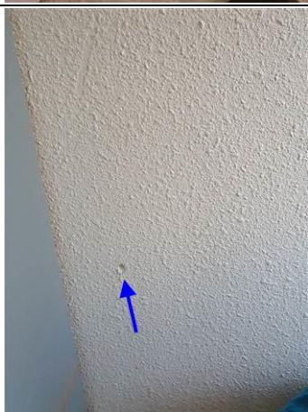
Photo n° PhA039 Localisation : 2ème étage - N2-25 Chambre 207 Ouvrage : 3 - Parois verticales intérieures - Cloisons sèches (assemblées, préfabriquées) Partie d'ouvrage : Mur Description : Matériau de type peinture (beige) ; matériau semi-dur de type enduit (blanc) ; matériau souple fibreux de type papier, carton (marron) ; matériau semi-dur de type plâtre (blanc)
