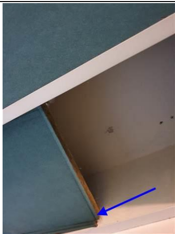
Photo n° PhA004 Localisation : Rez de chaussée - N0-13 Salle de douche Ouvrage : 4. Plafonds et faux-plafonds - Faux-plafonds Partie d'ouvrage : Plafond Description : Matériau (bleu) ; matériau fibreux de type isolant (jaune) ; matériau (pulvérulent) (gris)
