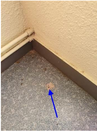
Photo n° PhA065 Localisation : 3ème étage - N3-41 Circulation Ouvrage : 5 - Planchers et planchers techniques - Revêtements de sols Partie d'ouvrage : Sol Description : Matériau de type colle (jaune) ; matériau semi-dur de type ragréage (rose)
