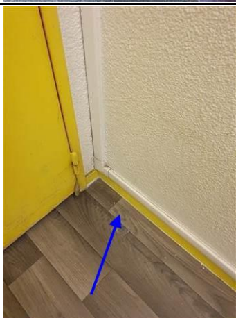
Photo n° PhA207 Localisation : 10ème étage - N10-50 Chambre 1001 Ouvrage : 5 - Planchers et planchers techniques - Revêtements de sols Partie d'ouvrage : Sol Description : Lino + colle + ragréage
