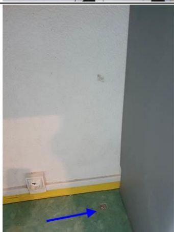
Photo n° PhA219 Localisation : 10ème étage - N10-56 Chambre 1027 Ouvrage : 5 - Planchers et planchers techniques - Revêtements de sols Partie d'ouvrage : Sol Description : Lino + colle + ragréage
