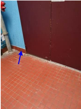
Photo n° PhA222 Localisation : 10ème étage - N10-68 Palier Ouvrage : 5 - Planchers et planchers techniques - Revêtements de sols Partie d'ouvrage : Sol Description : Matériau dur de type carrelage, faïence (rouge) ; matériau dur de type ciment-colle (gris) (granulaire) ; matériau dur (gris) (clair)
