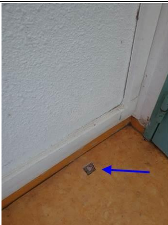
Photo n° PhA024 Localisation : 1er étage - N1-31 Chambre 106 Ouvrage : 5 - Planchers et planchers techniques - Revêtements de sols Partie d'ouvrage : Sol Description : Ragréage + colle noire
