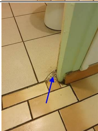
Photo n° PhA246 Localisation : Rez de chaussée - N0-19 WC Ouvrage : 5 - Planchers et planchers techniques - Revêtements de sols Partie d'ouvrage : Sol Description : Matériau dur de type carrelage, faïence (gris) ; matériau dur de type ciment-colle (gris) (clair)
