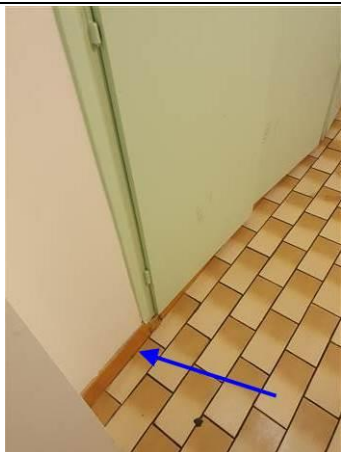
Photo n° PhA245 Localisation : Rez de chaussée - N0-20 Circulation Ouvrage : 3 - Parois verticales intérieures - Murs et cloisons maçonnés Partie d'ouvrage : Plinthe Description : Plinthe carrelage + colle
