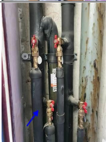
Photo n° PhA187 Localisation : 10ème étage - N10-39 Circulation Ouvrage : 6 - Conduits et accessoires intérieurs - Conduits de fluides (air, eau, vapeur, fumée, échappement, autres fluides) Partie d'ouvrage : Calorifuge (tresses, coquilles, matelas...) Description : Armaflex
