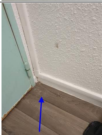
Photo n° PhA120 Localisation : 6ème étage - N6-33 Chambre 605 Ouvrage : 5 - Planchers et planchers techniques - Revêtements de sols Partie d'ouvrage : Sol Description : Lino + colle + ragréage
