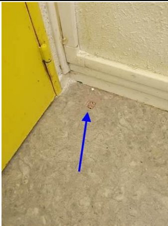
Photo n° PhA035 Localisation : 2ème étage - N2-46 Chambre 203 Ouvrage : 5 - Planchers et planchers techniques - Revêtements de sols Partie d'ouvrage : Sol Description : Matériau de type colle (jaune) ; matériau semi-dur de type ragréage (rose) ; matériau de type colle bitumineux (noir)
