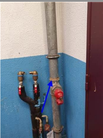
Photo n° PhA226 Localisation : 10ème étage - N10-68 Palier Ouvrage : 6 - Conduits et accessoires intérieurs - Conduits de fluides (air, eau, vapeur, fumée, échappement, autres fluides) Partie d'ouvrage : Conduit Description : Filasse
