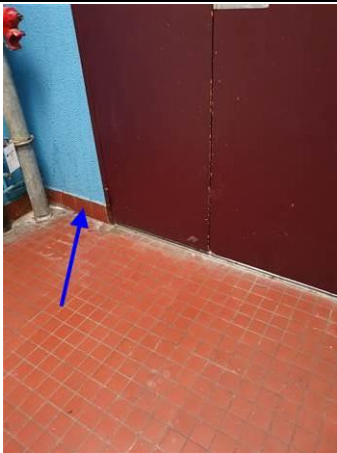
Photo n° PhA223 Localisation : 10ème étage - N10-68 Palier Ouvrage : 3 - Parois verticales intérieures - Murs et cloisons maçonnés Partie d'ouvrage : Plinthe Description : Matériau (pulvérulent) (noir) (vert) ; matériau dur de type joint ciment (gris)
