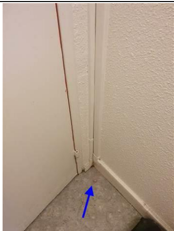
Photo n° PhA038 Localisation : 2ème étage - N2-25 Chambre 207 Ouvrage : 5 - Planchers et planchers techniques - Revêtements de sols Partie d'ouvrage : Sol Description : Matériau de type colle (jaune) ; matériau semi-dur de type ragréage (rose) ; matériau (cimenteux) (gris) en traces
