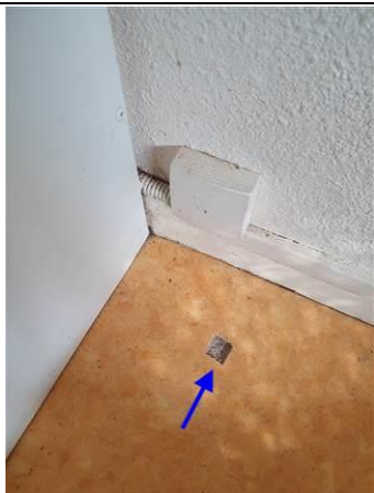
Photo n° PhA017 Localisation : 1er étage - N1-11 Chambre 115 Ouvrage : 5 - Planchers et planchers techniques - Revêtements de sols Partie d'ouvrage : Sol Description : Ragréage + colle noire
